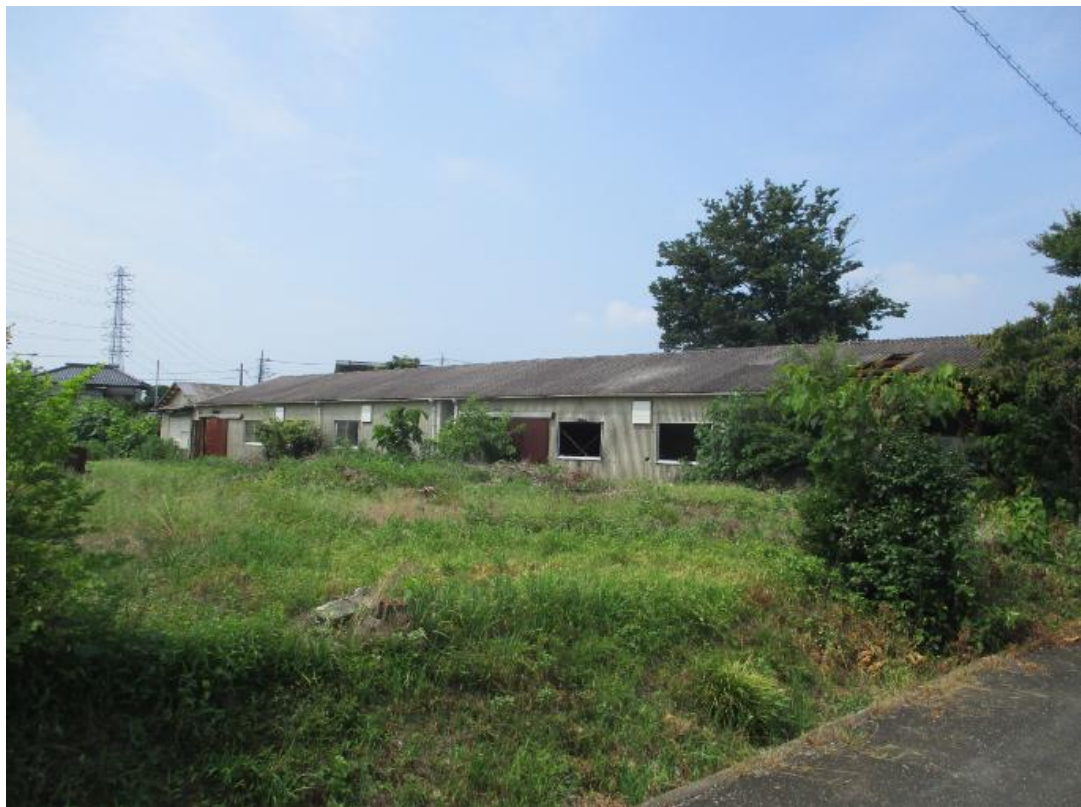
北東側より撮影
