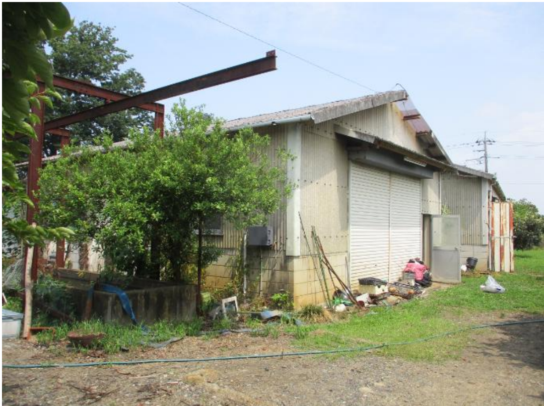
浸水槽付近から撮影
