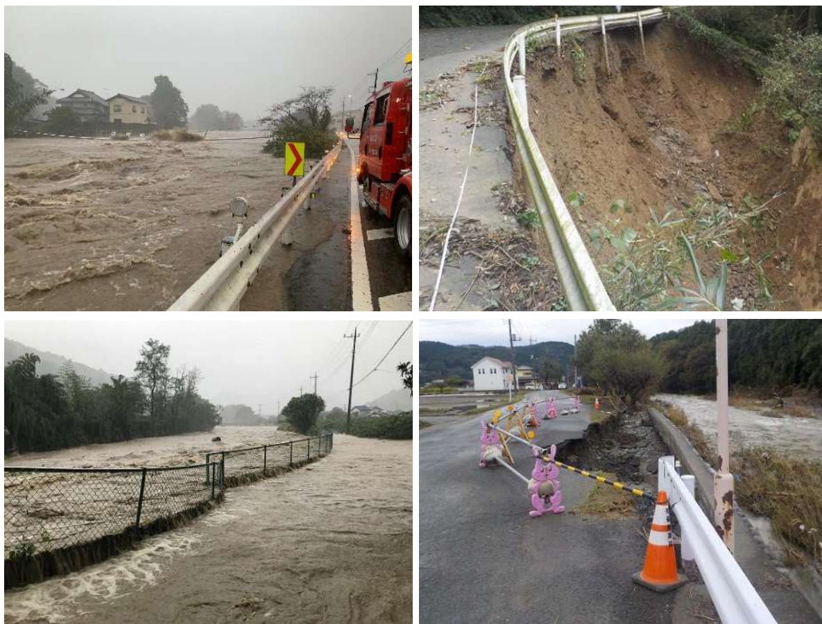
令和元年東日本台風による被害状況より
