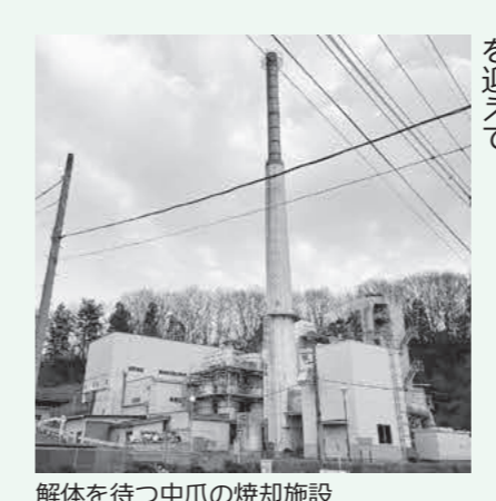
解体を待つ中爪の焼却施設
