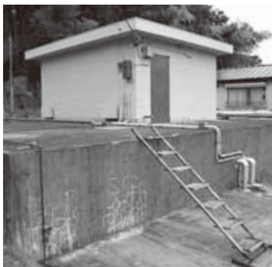
管路の改修助成の請願が採択された 深田団地の下水処理施設
