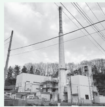
解体を待つ中爪の焼却施設
