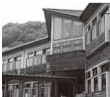
木造の萩ヶ丘小学校(ときがわ町)
