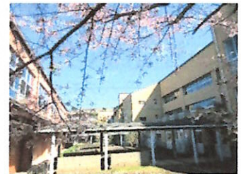
小川中学校校舎 令和8年4月2日撮影
