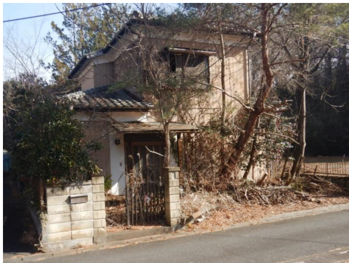
【管理不全な空き家】
