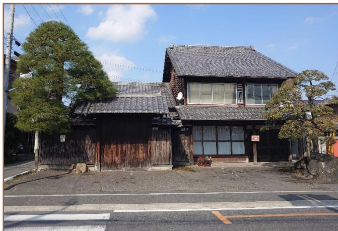
2階建ての建物の前に局舎はあった
