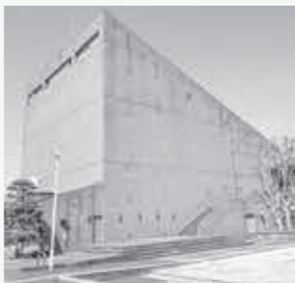
解体予定の町民会館ホール棟
