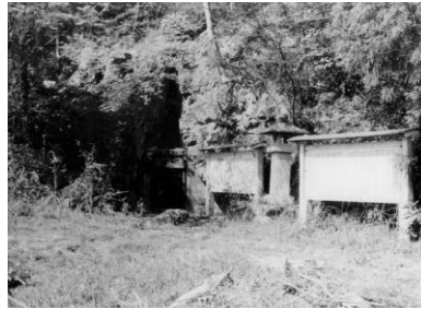
図26. 入口コンクリート閉塞後(昭和54年)
