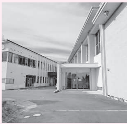
小学校として整備される予定の西中
