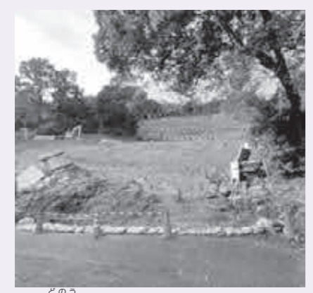
大型土嚢袋が千鳥配置された堤体外見
