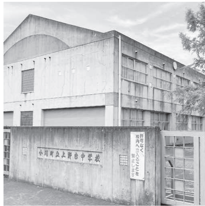
公共施設の適正管理の中で、今後も進む統廃合や複合化による各施設の跡地利用の良い前例になることを期待しています。
