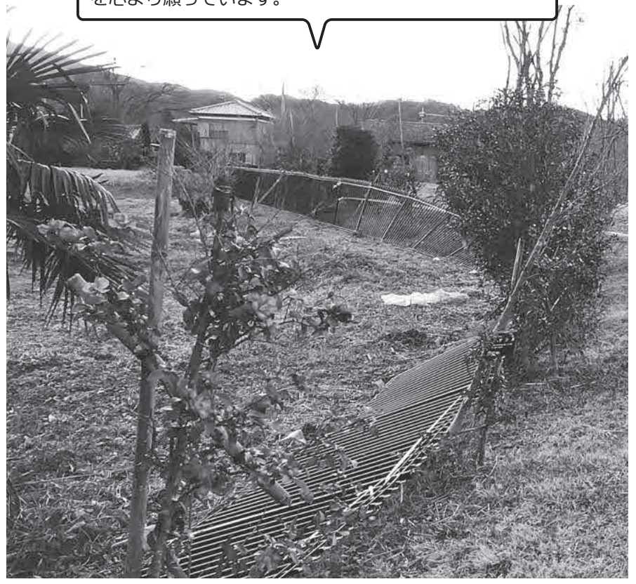
憩いの場所、栃本親水公園の南側のフェンス。この度の台風19号で被災した各地域の一日も早い復旧を心より願っています。
