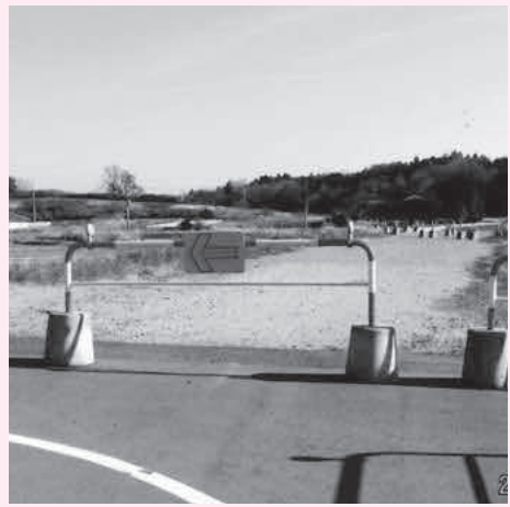
町民みんなが願う。全面開通が待たれる県道本小川線バイパス。
