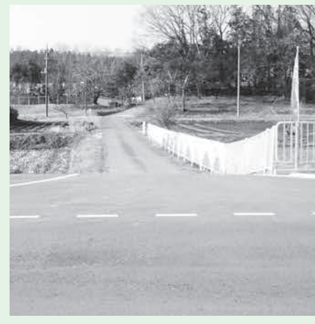
町道228号線からの総合運動場出入り口付近道路。
