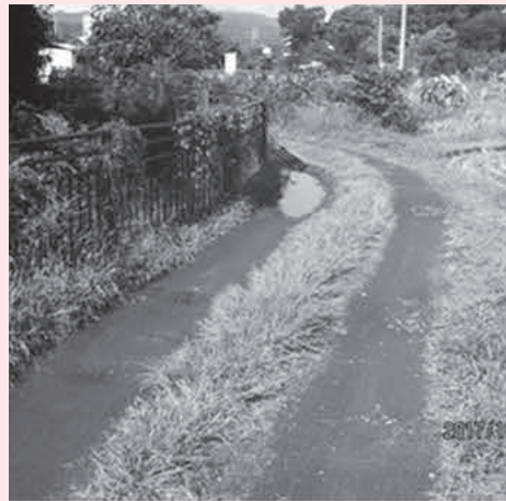
道幅の狭い市街化区域内未整備道路。
