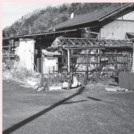
昭和30年代築の老朽化した町営住宅。
