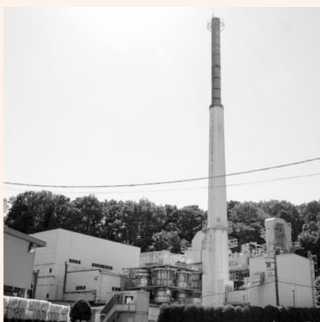
老朽化した小川地区衛生組合ごみ処理施設。
