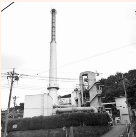
建設当初から42年が経過した小川地区衛生組合の「ごみ焼却場」。
