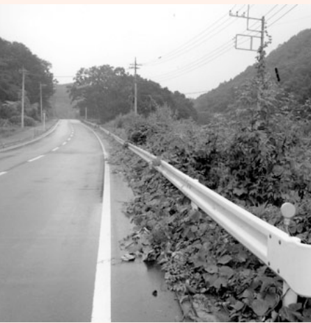
安全のため除草が待たれる町道228号線周辺
