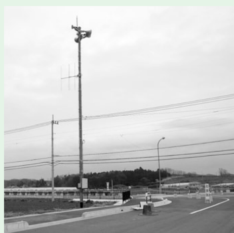
利用拡大を望む防災無線と完成間近の町道228号線。
