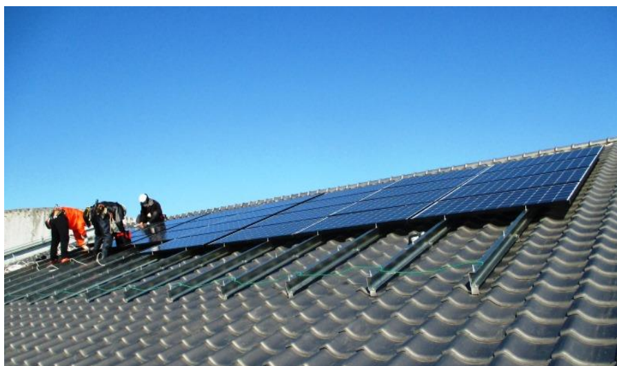
竹沢公民館の屋根に太陽光パネル設置作業中
