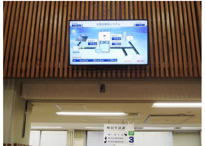
発電状況をお知らせするモニター（庁舎）
