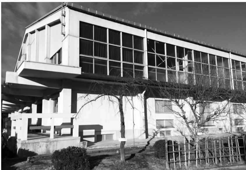
雨漏りなどの修繕が行なわれる東中学校体育館
