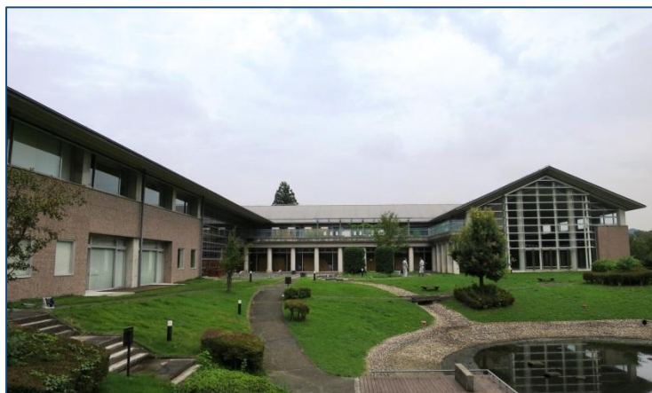
太陽光発電設備等を整備する総合福祉センター
