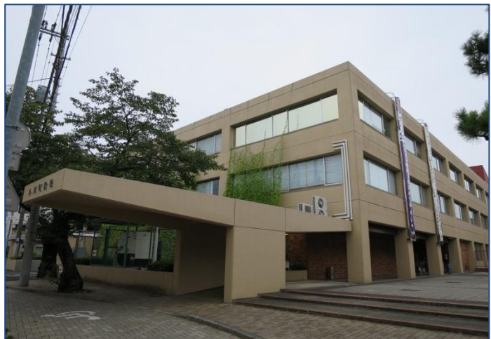
太陽光発電設備等を整備する庁舎
