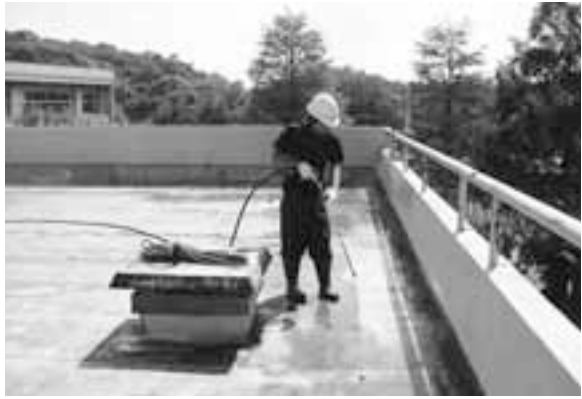
東中学校屋上工事
