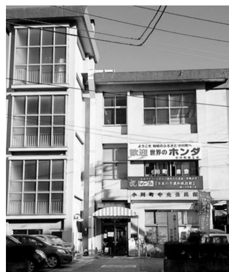
老朽化が進む中央公民館
