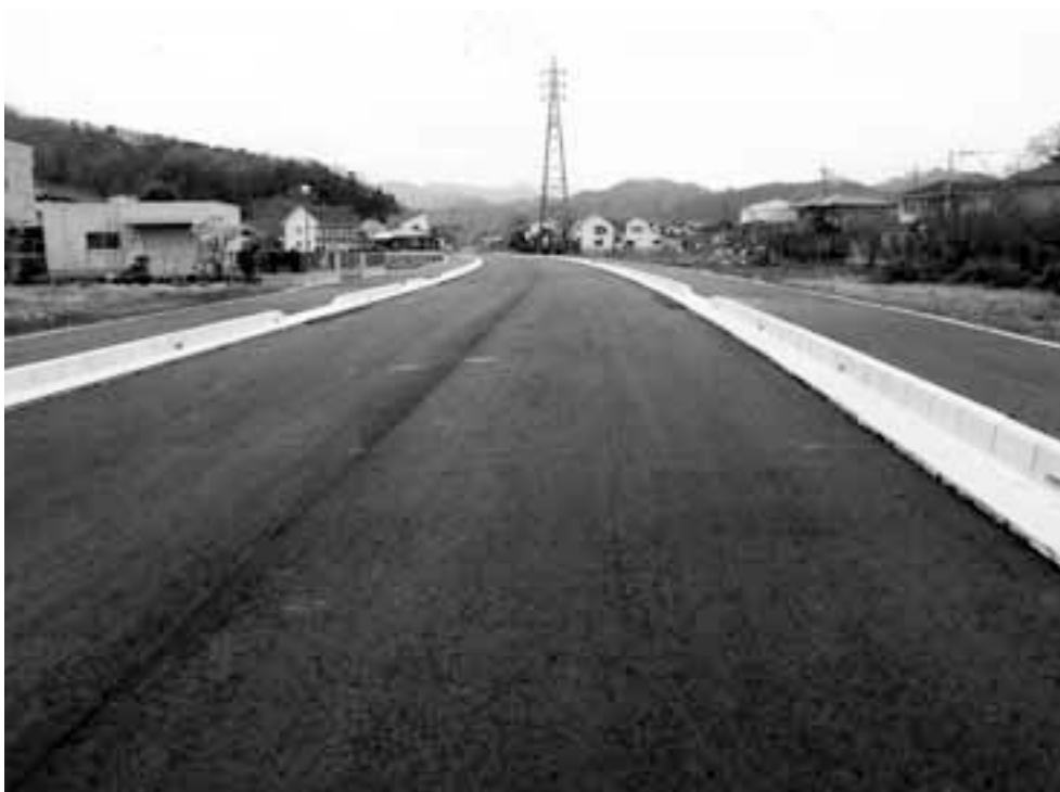
工事が進む環状1号線（青下田島区内）
