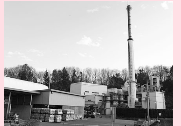
小川地区衛生組合ごみ焼却場
