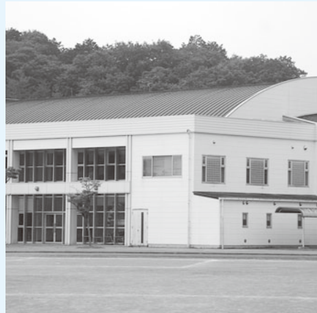
太陽光発電設備と蓄電池の設置が期待されるみどりが丘小学校体育館。
